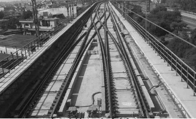
डीएमआरसी सीटी-4 के बादली का गिट्टी रहित रेलपथ
